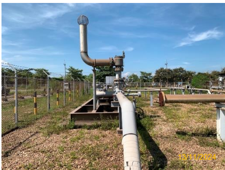
ภาพที่ 2.2-40 การติดตั้ง Pressure Relief Valve
