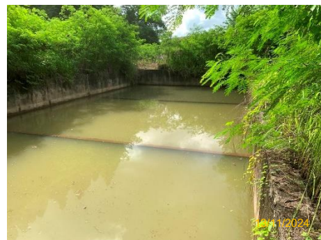
ภาพที่ 2.2-14 ปอดกตะกอนสำหรับรองรับน้ำฝน บริเวณพื้นที่ลานกองเศษเหล็ก
